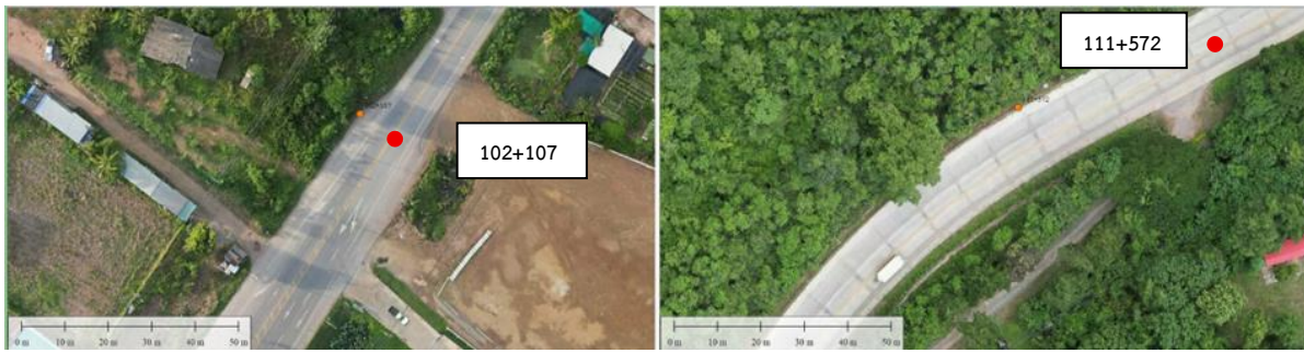
รูปที่ 4-5 ภาพถ่ายโดรนบริเวณ กม.102+107 และ กม. 111+572
