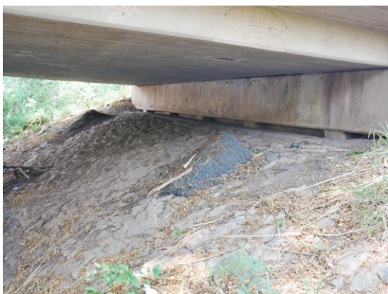
(จ) คอสะพาน
