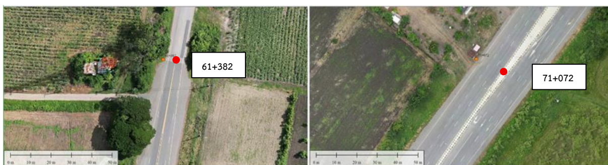
รูปที่ 4-4 ภาพถ่ายโดรนบริเวณ กม. 61+382 และ กม. 71+072
