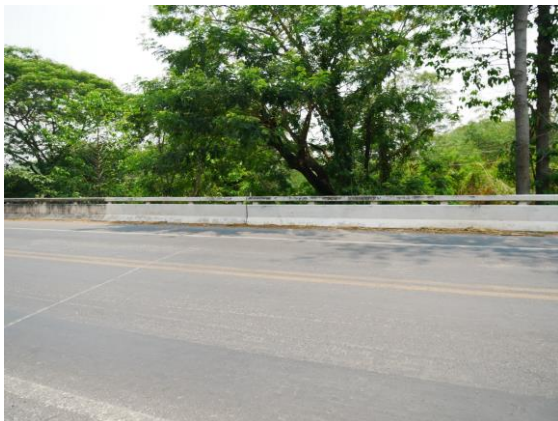
(ค) พื้นสะพาน
