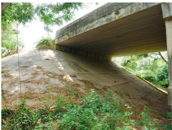
(จ) คอสะพาน
