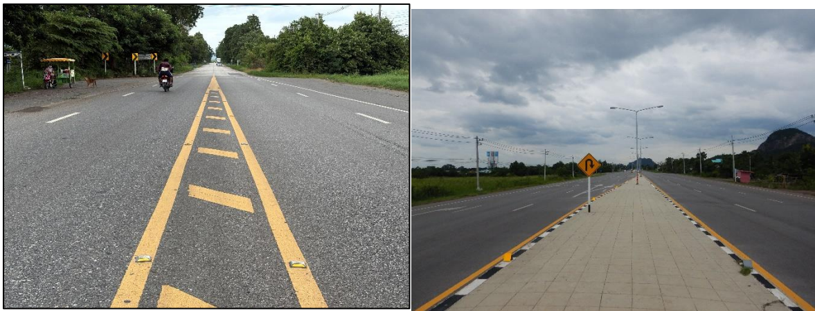
รูปที่ 4-6 สภาพโครงการพื้นที่ปัจจุบัน กม. 61+382 และ กม. 71+072
