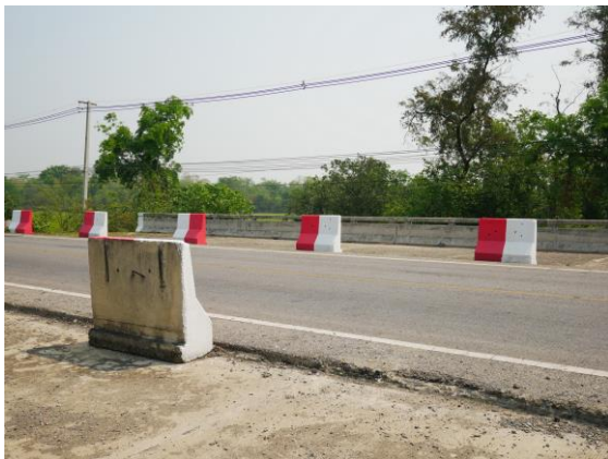
(ค) พื้นสะพาน
