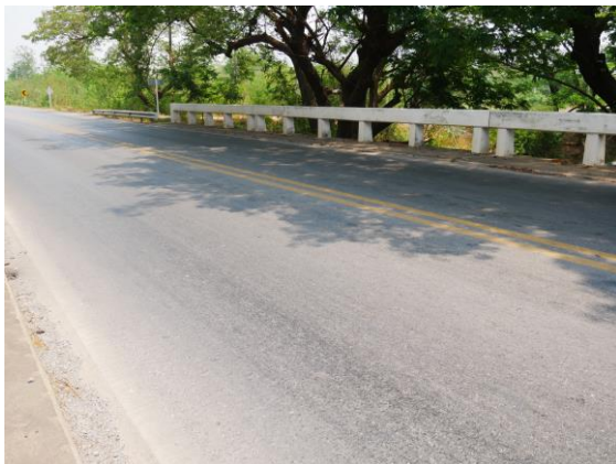
(ค) พื้นสะพาน
