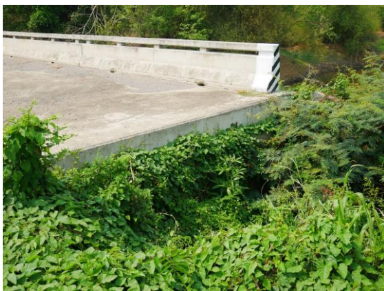
(จ) คอสะพาน
