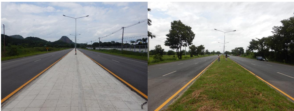
รูปที่ 4-7 สภาพโครงการพื้นที่ปัจจุบัน กม. 67+200 - 68+360 และ กม. 69+950 - กม. 71+072
