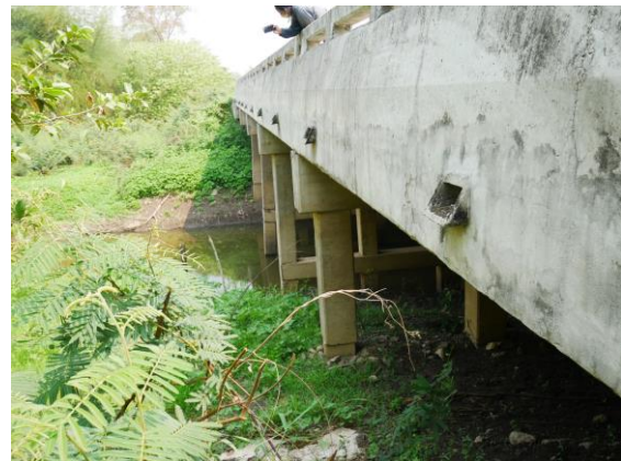
(ง) ตอม่อและคานขวางสะพาน
