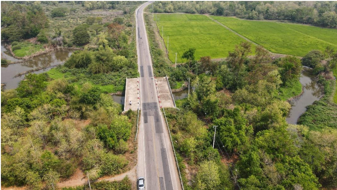
รูปที่ 4-2 สภาพปัจจุบันทางหลวงหมายเลข 205 ตอนควบคุมที่ 0202 (คลองห้วยไผ่-เทศบาลลำน้ำรายณ์)
