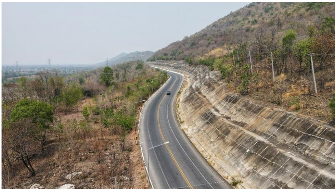
รูปที่ 4-3 สภาพปัจจุบันทางหลวงหมายเลข 205 ตอนควบคุม (เทศบาลลำน้ำรายณ์ – ช่องสำราญ)
