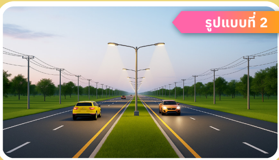
เกาะกลางแบบยก (Raised Median) เป็นรูปแบบเกาะกลางที่เหมาะสมช่วงในเขตชุมชน
