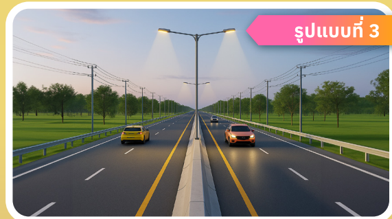
เกาะกลางแบบราวกันหรือกำแพง (Barrier Median) เป็นรูปแบบเกาะกลางที่เหมาะสมช่วงนอกเขตชุมชน
