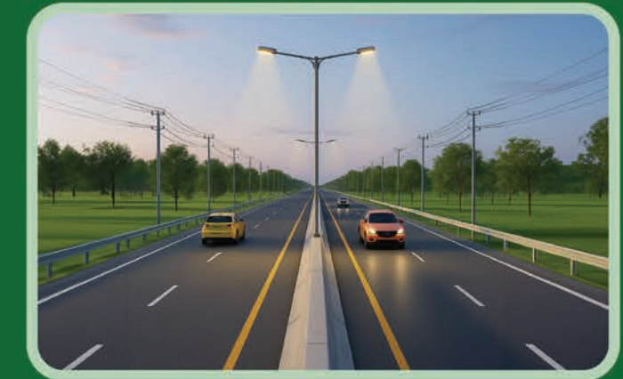
ทางหลวง 4 ช่องจราจรที่มีเกาะกลางแบบราวกันหรือกำแพง (Barrier Median)
