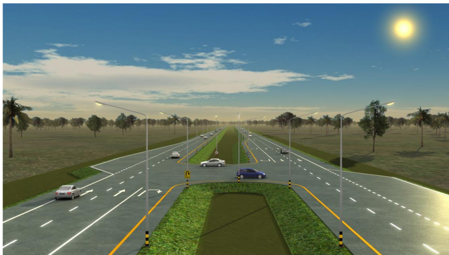
รูปที่ 4-8 จุดกลับรถระดับพื้นสำหรับเกาะแบบยก (At-Grade U-turn for Raised Median)
