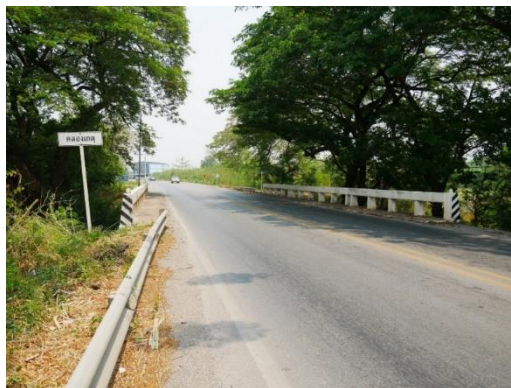
รูปที่ 4-14 สะพานคลองเกตุ
